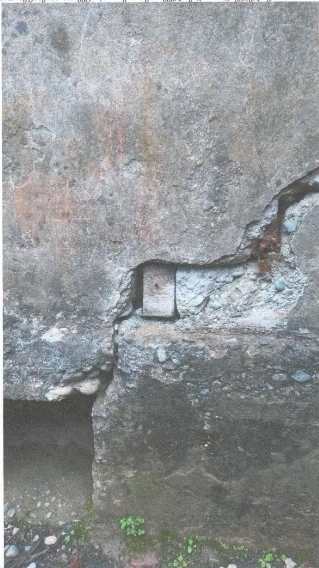
სურათი №2. შეფასების ობიექტი (ბზარები ზეძირკველზე და მზიდ კედელზე)
