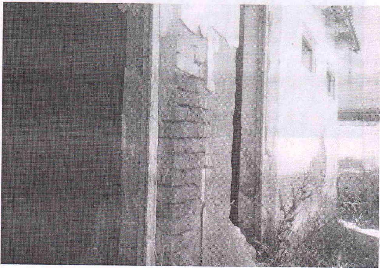
Fig. 10. - Parte del muro de la casa de la familia de los señores Gómez, que se conserva en su parte superior y que muestra la construcción de la parte inferior con ladrillo y la superior con piedra.
